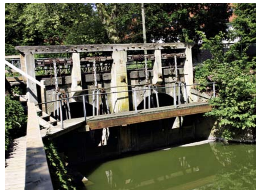
Arresødalbroen med slusen, som styrer vandstanden i Arresøen.
